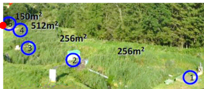
▲施工 4 年後 ヨシが成長して表面を覆っている
