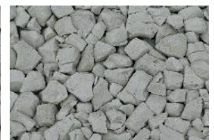
転圧後 (1t 振動ローラー 4 回後)
